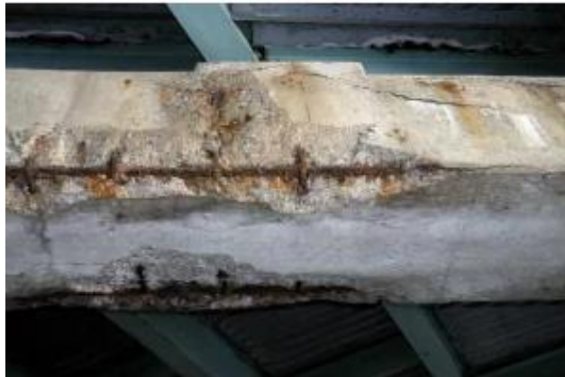
Figura 2 - Processo de carbonatação
