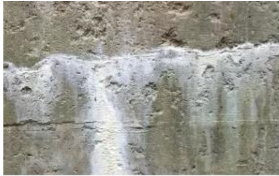
Figura 3 - Processo de lixiviação
