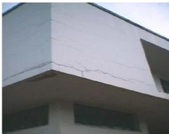
Figura 5 - Fissuras Horizontais
