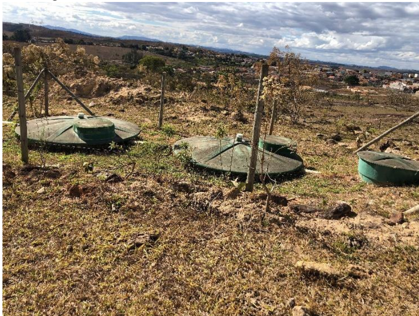
Figura 13 – ETEC localizada no loteamento Ponte Alta
