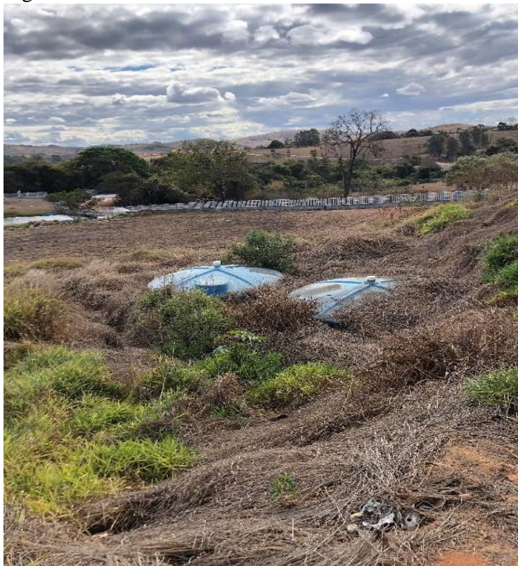
Figura 12 – ETEC 2 – localizada no loteamento Joan Pool
