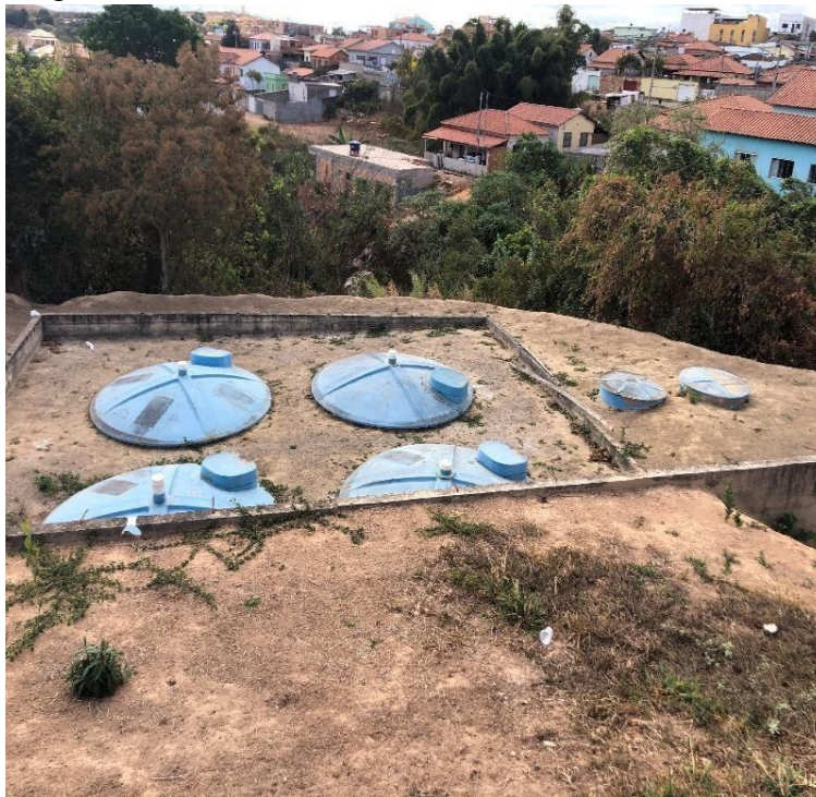
Figura 11 – ETEC 1 localizada no loteamento Joan Pool
