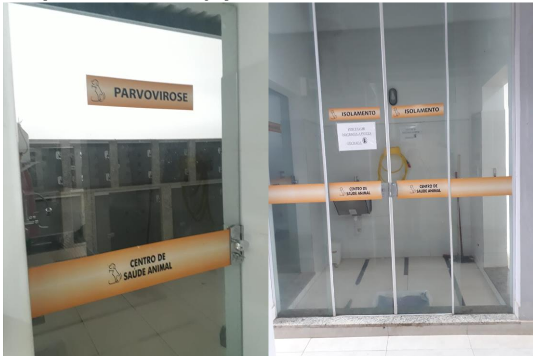
Figura 15 – Vistas parciais das portas de vidro temperado e das baias do canil de isolamento de parvovirose da Clínica Agropec Centro de Saúde Animal – Bambuí/MG
