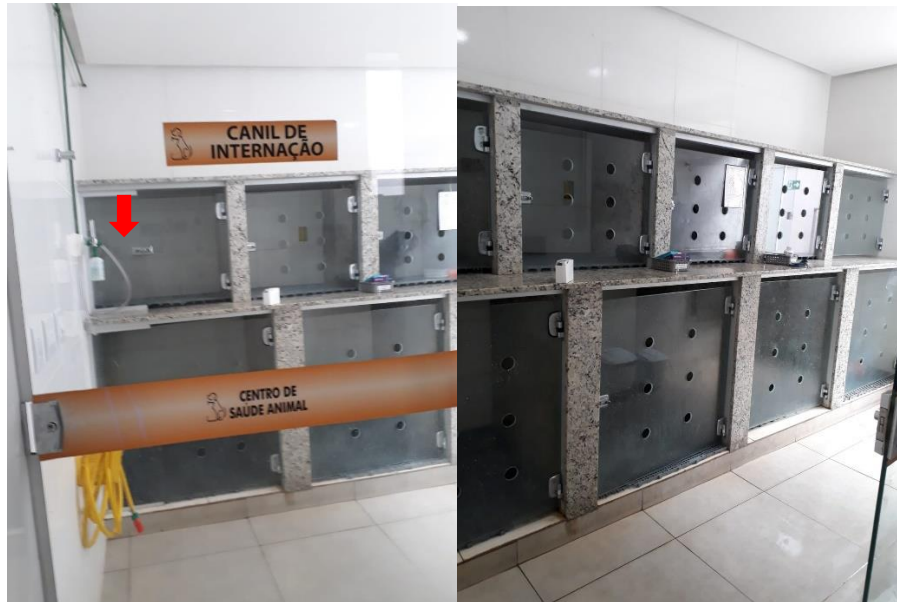
Figura 12 – Vistas parciais da porta de vidro temperado e das baias do primeiro canil de internação da Clínica Agropec Centro de Saúde Animal – Bambuí/MG
