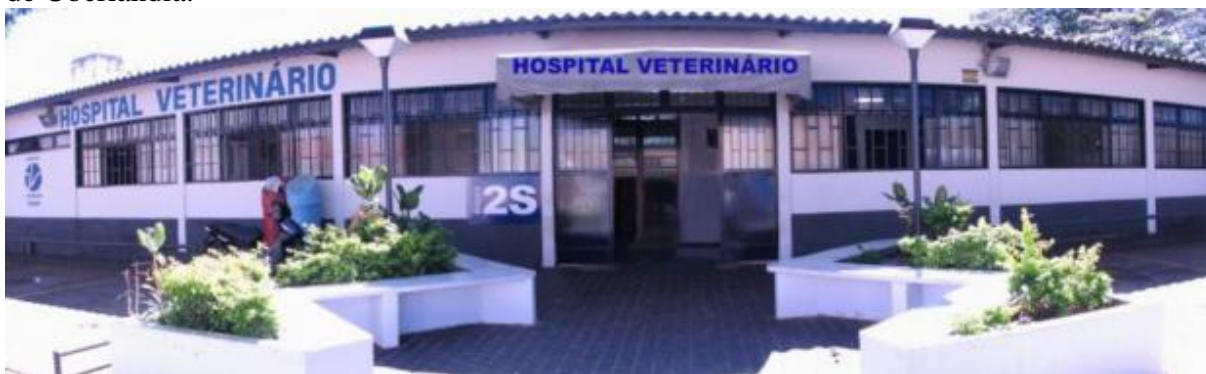
FIGURA 1 – Vista panorâmica da fachada do Hospital Veterinário da Universidade Federal de Uberlândia.
