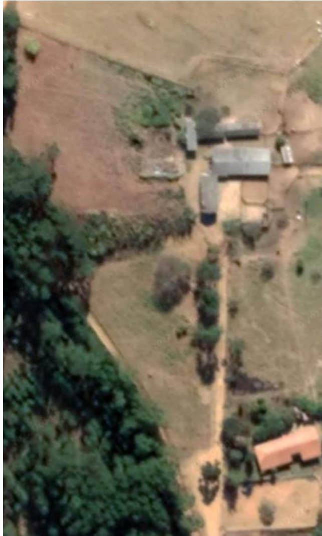
Figura 25: Vista de cima do Centro de Treinamento Equestre Rio Verde
