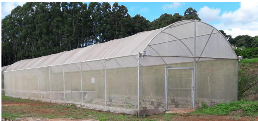
Figura 1. Estrutura de casa de vegetação coberta por clarite.
