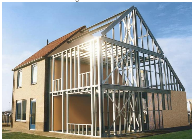
Figura 1 - Estrutura em Light Steel Frame e sistema de vedação.
