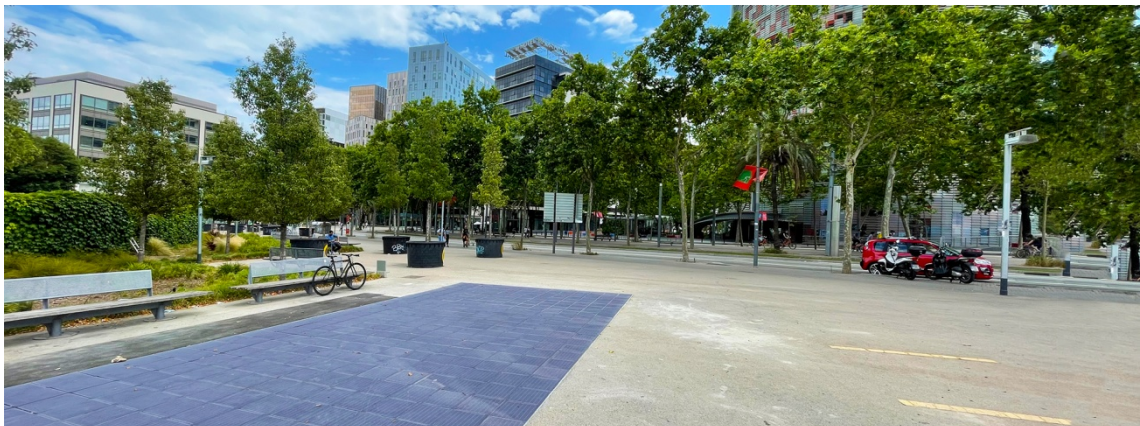
Figura 30: 56 m 2 de pavimento solar Platío no parque Glories em Barcelona, Espanha
