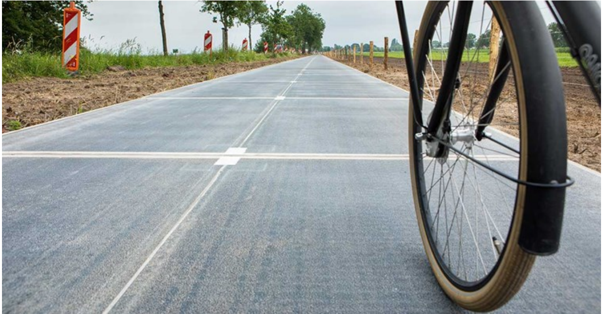
Figura 15: Pavimento com placas SolaRoad
