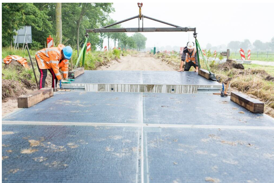
Figura 14: Montagem SolaRoad
