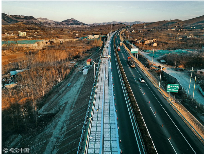
Figura 23: Instalação dos dispositivos fotovoltaicos em Jinan, China.
