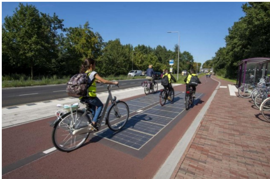
Figura 20: Ciclovía com pavimentos Wattway em Grave, Holanda
