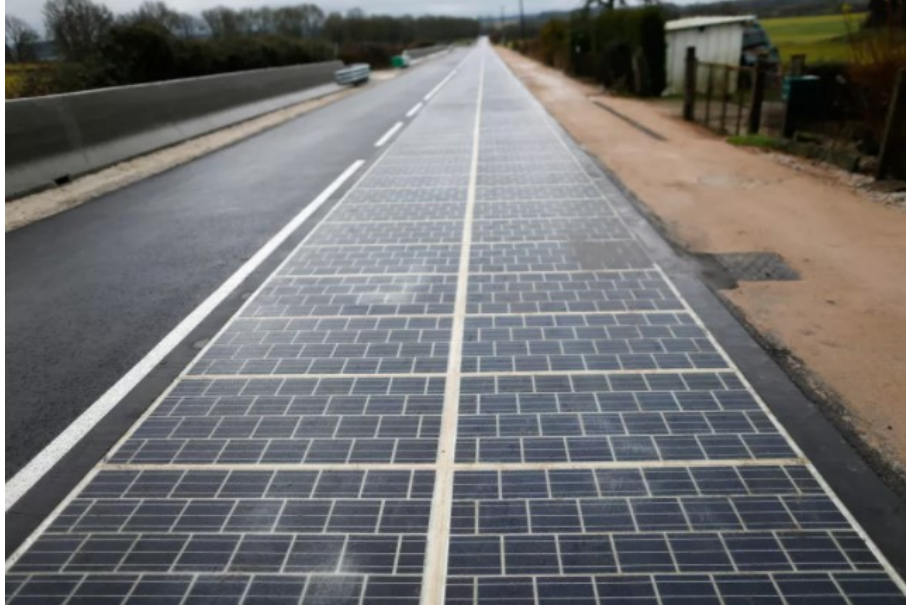
Figura 17: Estrada de painéis solares em Touruvre, França
