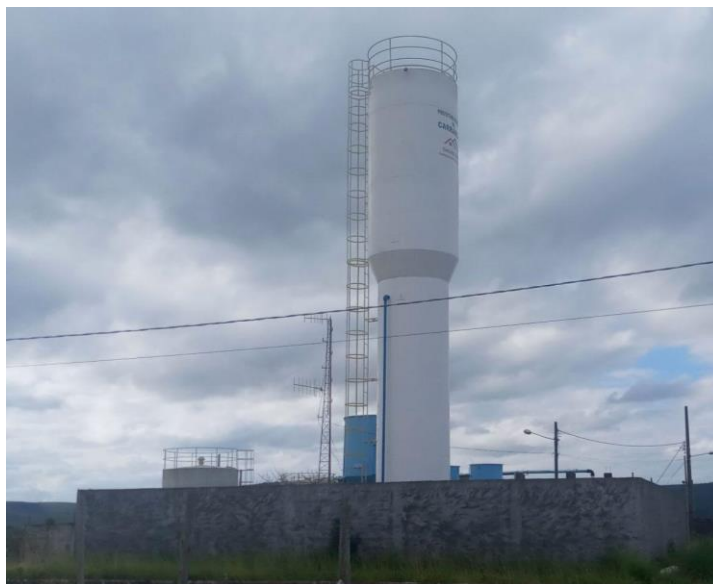
Figura 6- Reservatório localizado no final da Avenida Brasil
