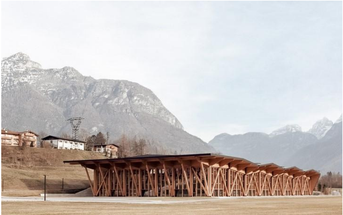
Figura 4- Vista externa do Centro de Exposição, Agordo, Itália.
