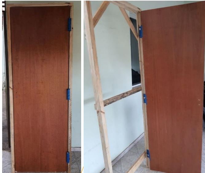
Figura 38: Dobradiças instaladas na porta
