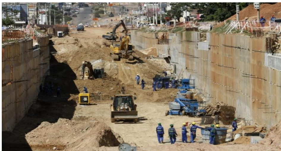
Figura 6 - Canteiro de obras longo e estreito.
