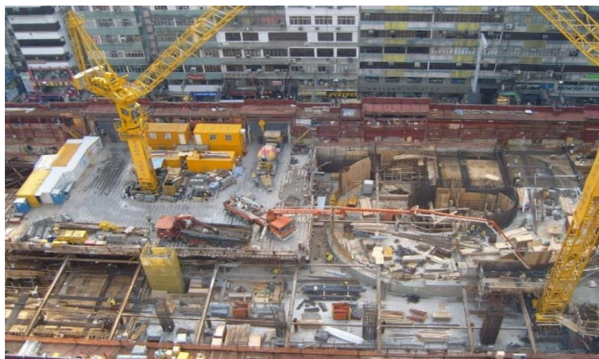
Figura 4 - Canteiro de obras restrito.
