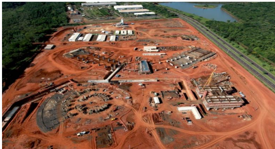
Figura 5 - Canteiro de obras amplo.
