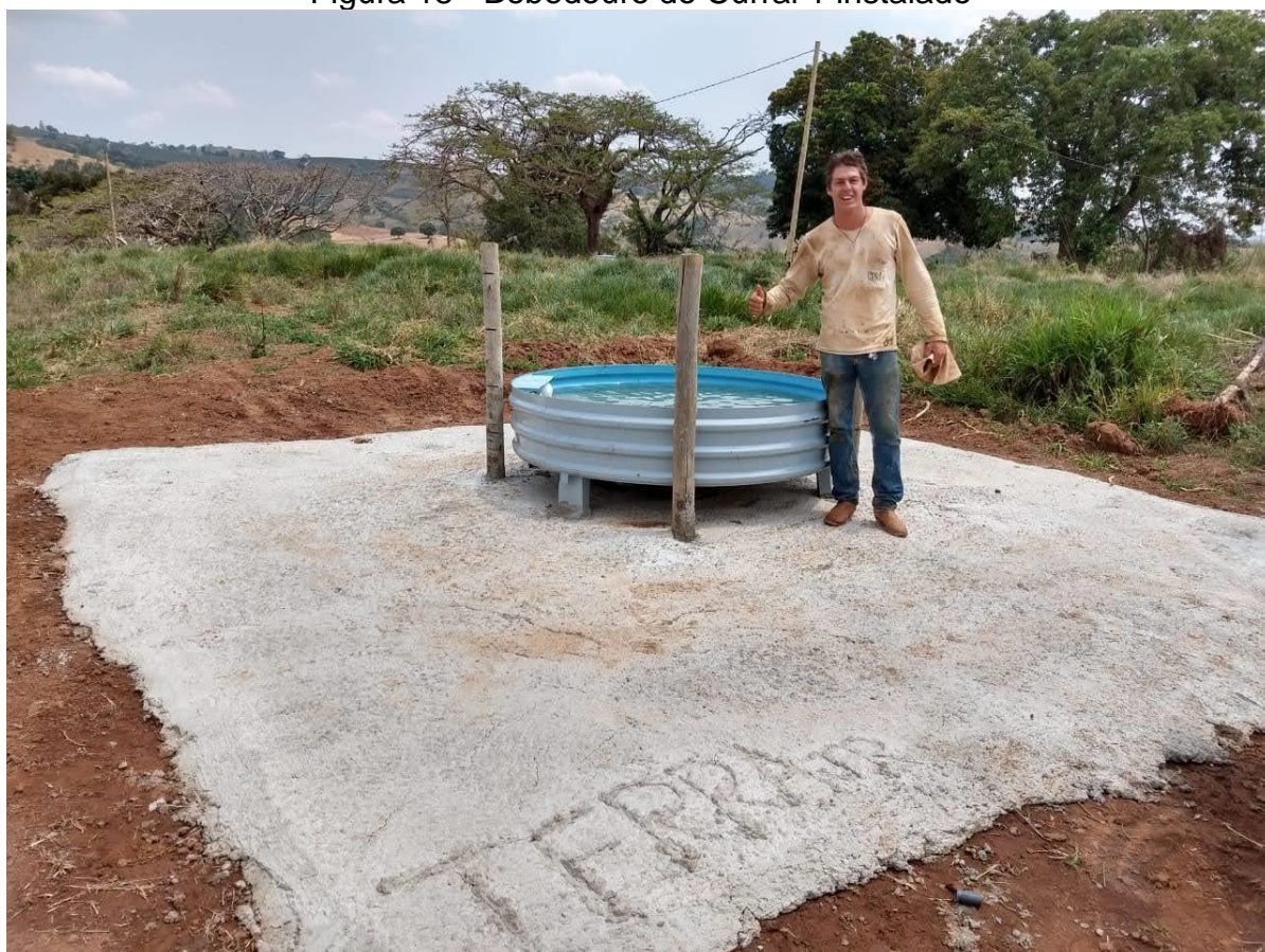
Figura 18 - Bebedouro do Curral 1 instalado
