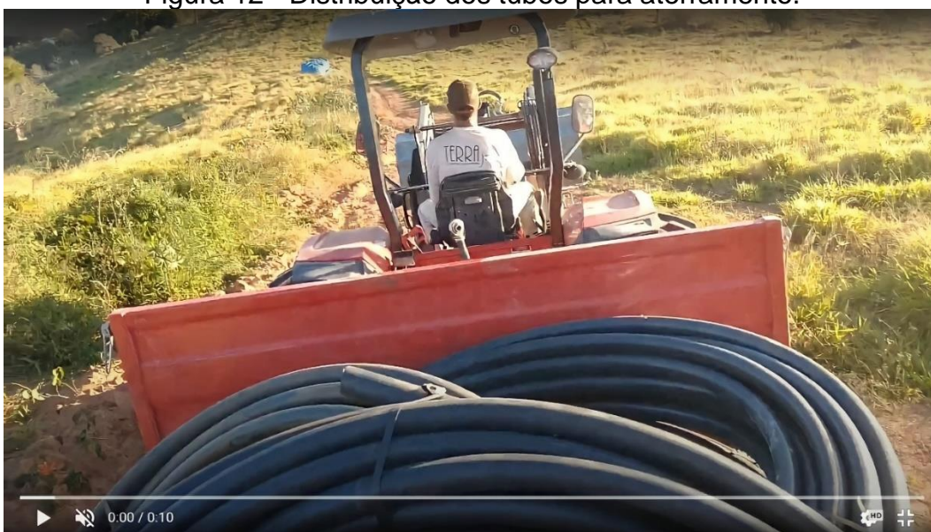
Figura 12 - Distribuição dos tubos para aterramento.
