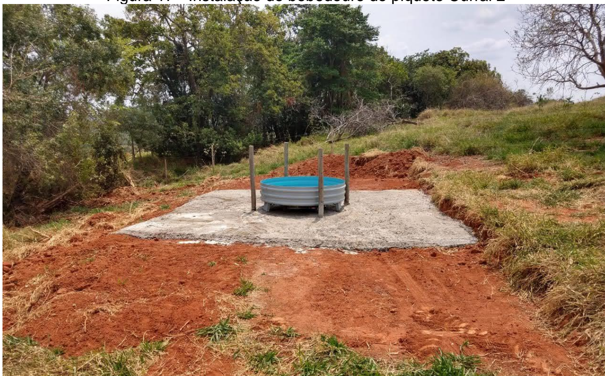
Figura 17 - Instalação do bebedouro do piquete Curral 2
