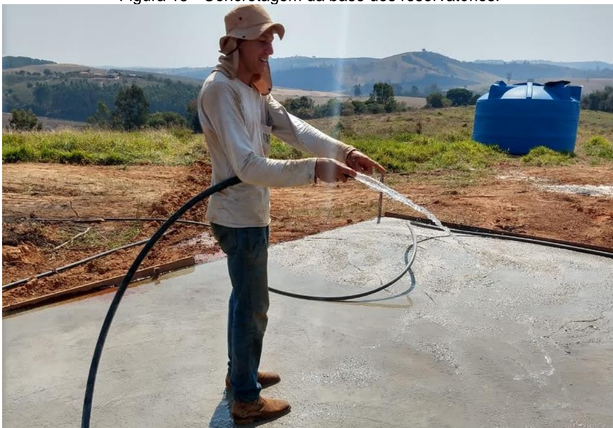
Figura 15 - Concretagem da base dos reservatórios.
