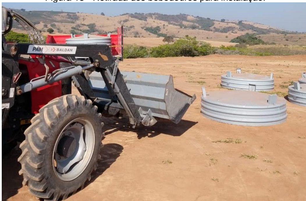
Figura 13 - Retirada dos bebedouros para instalação.
