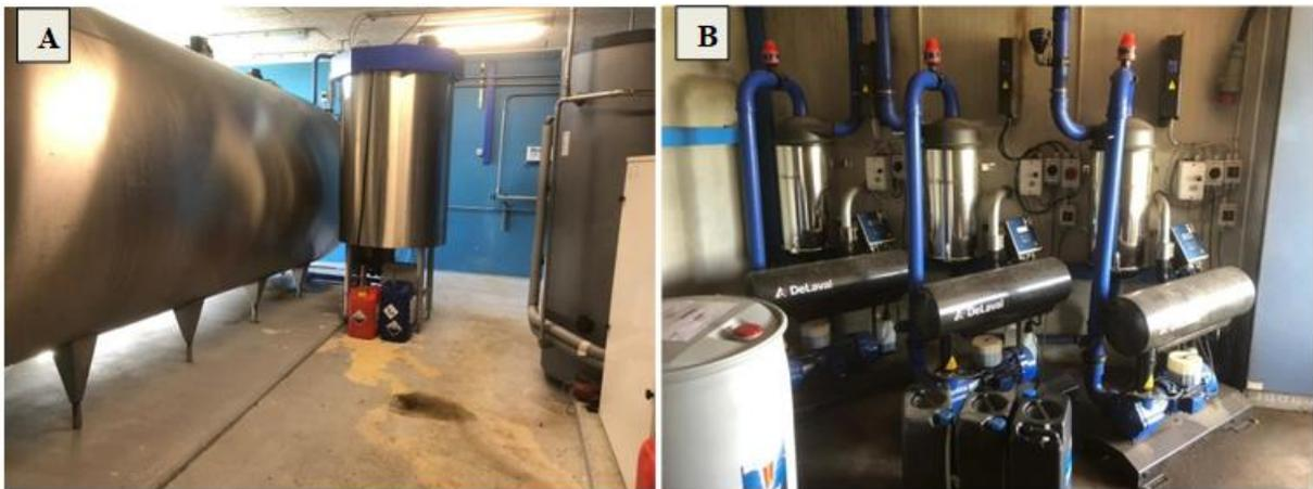
Legenda: Sala de tanque de expansão refrigerado para o armazenamento do leite (A). Sala de máquinas com os motores responsáveis pelo funcionamento dos robôs e os demais produtos utilizados (B).
