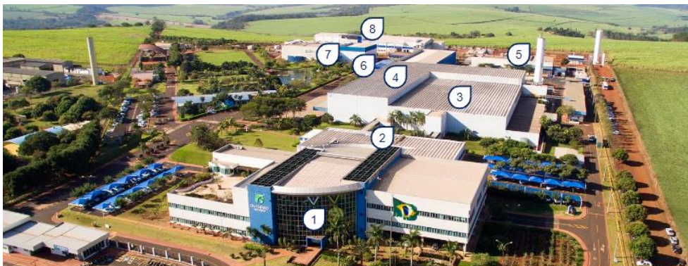
Figura 1 – Vista aérea das instalações fabris e corporativas da Empresa Ouro Fino Agronegócio Ltda., em que foi realizado o estágio supervisionado, no período de 19/07/2021 a 31/12/2021.
