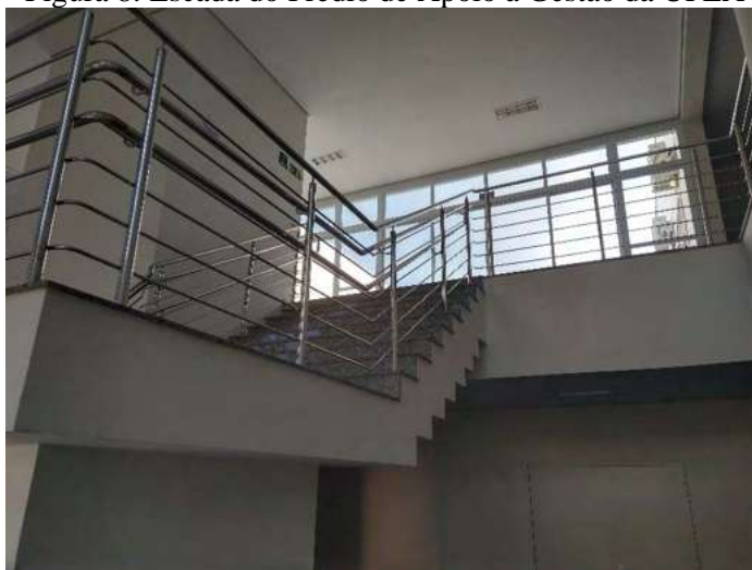
Figura 8: Escada do Prédio de Apoio à Gestão da UFLA
