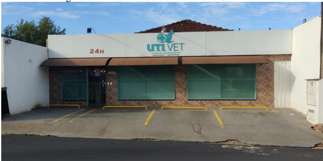
Figura 1 - Faixada do Centro Veterinário UTIVET.
