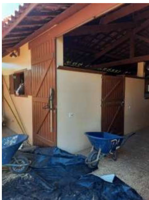
Figura 20: Estrutura externa das baias de garanhões.
