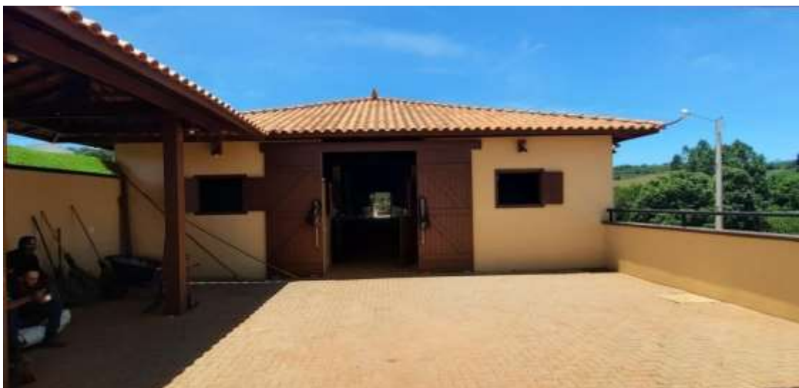
Figura 18: Galpão de baias
