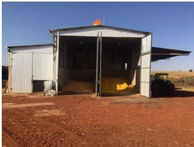
Figura 19 – Galpão Armazenagem de milho e DDGS Faz São Pedro
