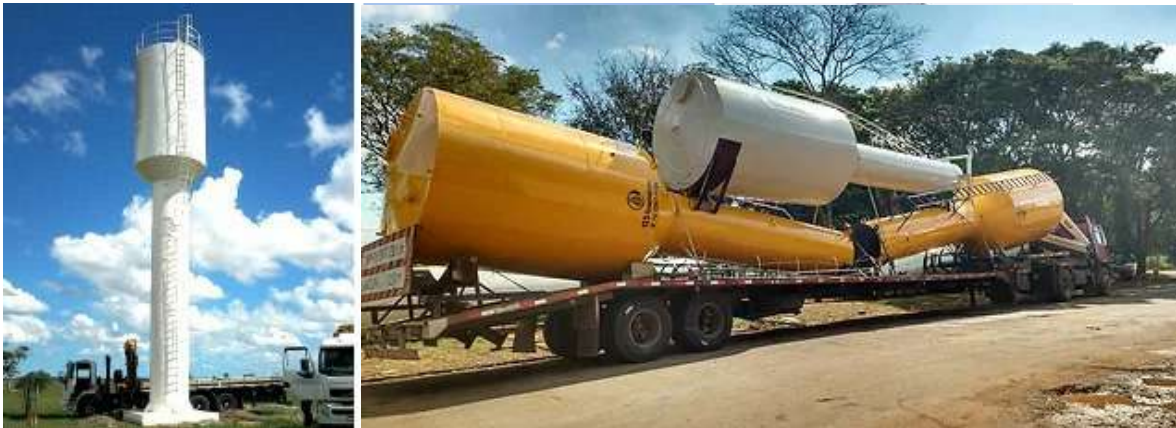
Figura 3.1 – Exemplos de reservatórios metálicos tipo taça.
