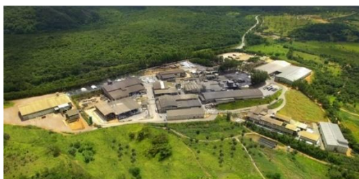
Figura 1 – Unidade de Sete Lagoas - MG
