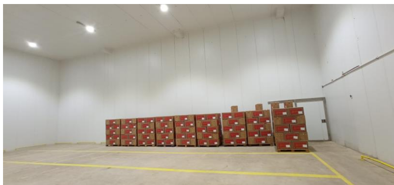
Figura 23 - Câmara frigorífica refrigerada para ovos de exportação.
