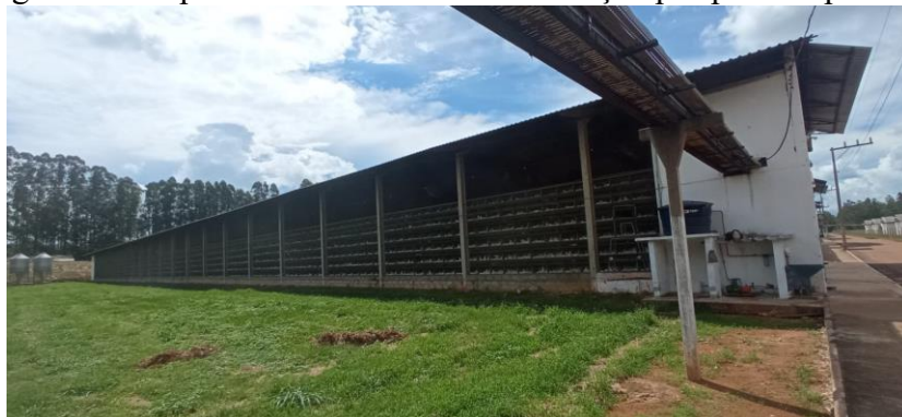
Figura 9 - Galpão convencional com ventilação por pressão positiva
