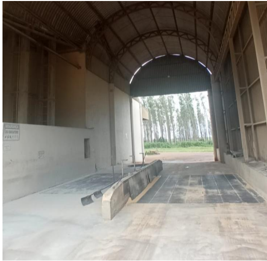
Figura 26 - Moegas onde os caminhões descarregam o farelo de soja e o calcário.
