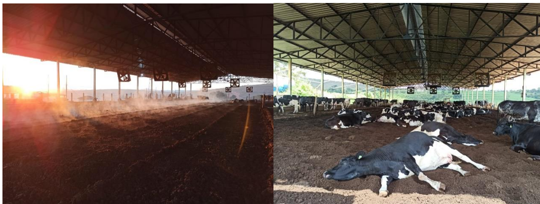
Figura 4 – Detalhe da instalação Compost Barn .
