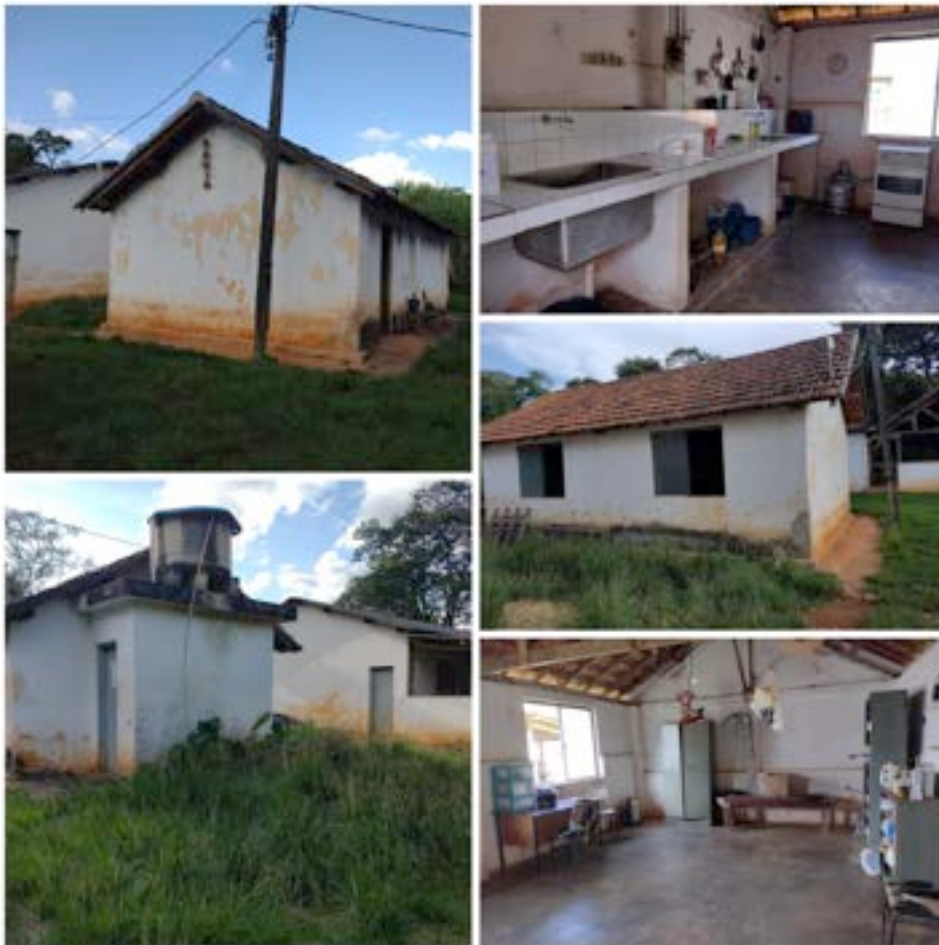
Figura 4 - Casa de Apoio
