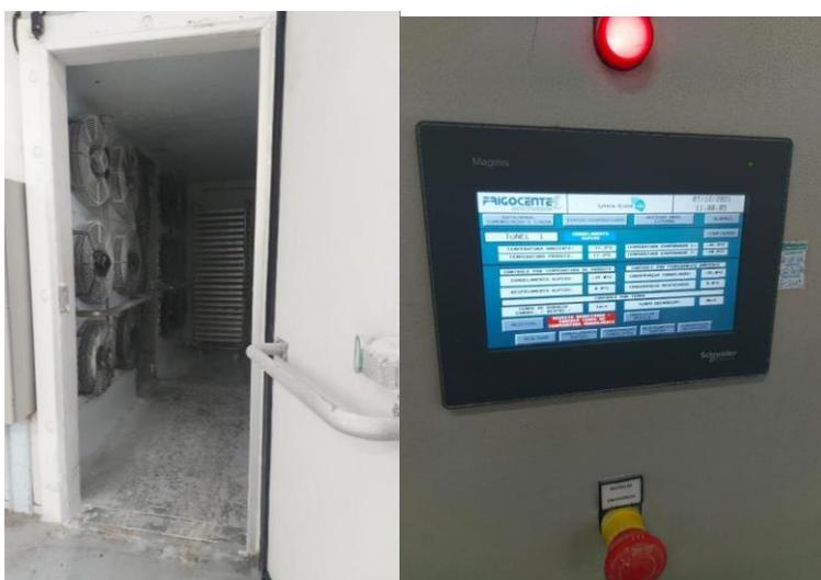
Legenda: Através da tela de comando, é possível controlar o fluxo de ar dentro do túnel de congelamento, sua velocidade, o tempo de congelamento necessário, a capacidade do túnel por hora.
