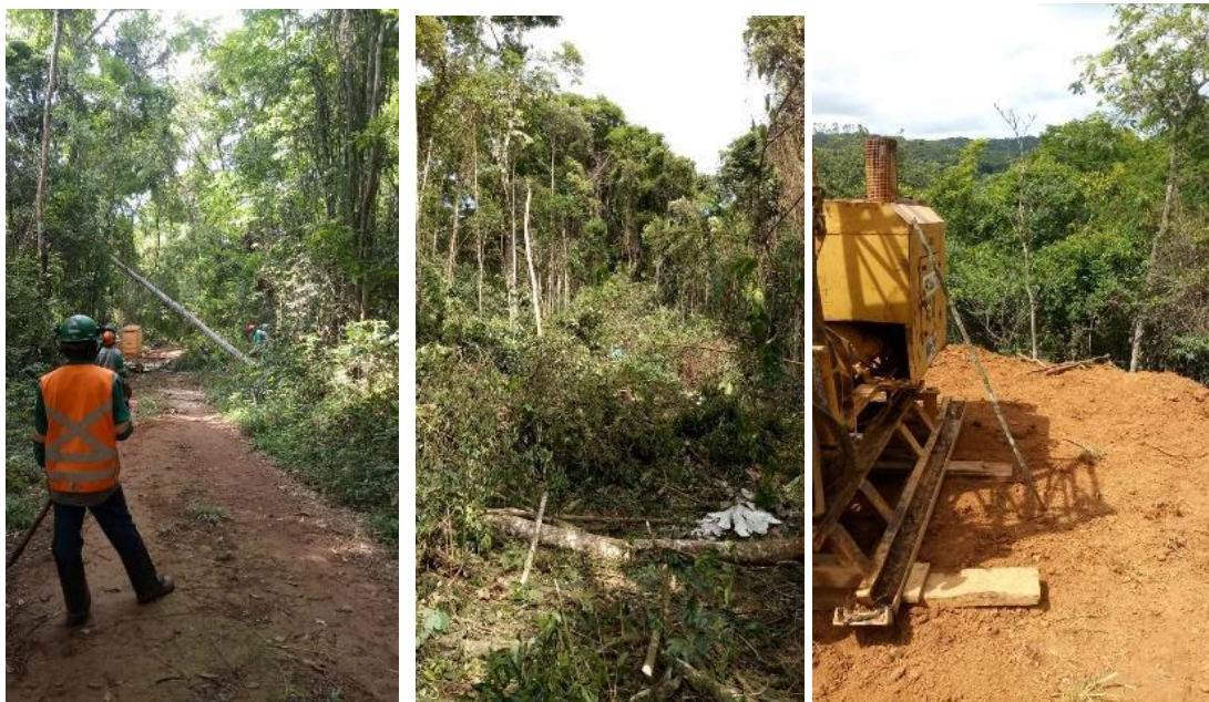
Figura 4 - Registros da supressão vegetal para formação de praças de sondagem.
