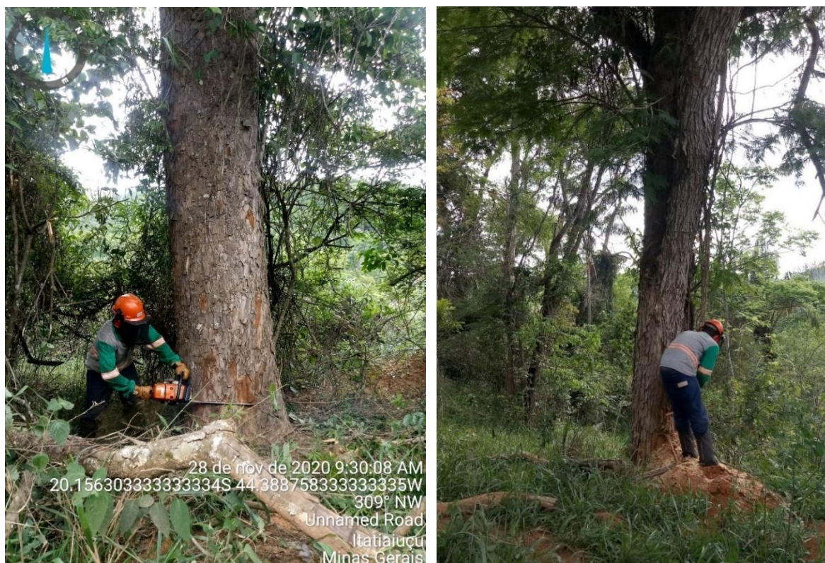
Figura 7 - Registro da etapa de abate de árvores com motosserra.
