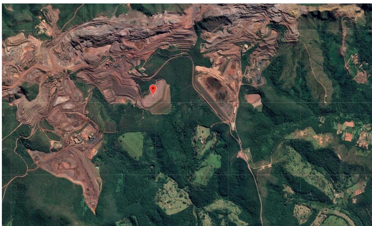
Figura 2 - Localização da barragem de rejeitos.
