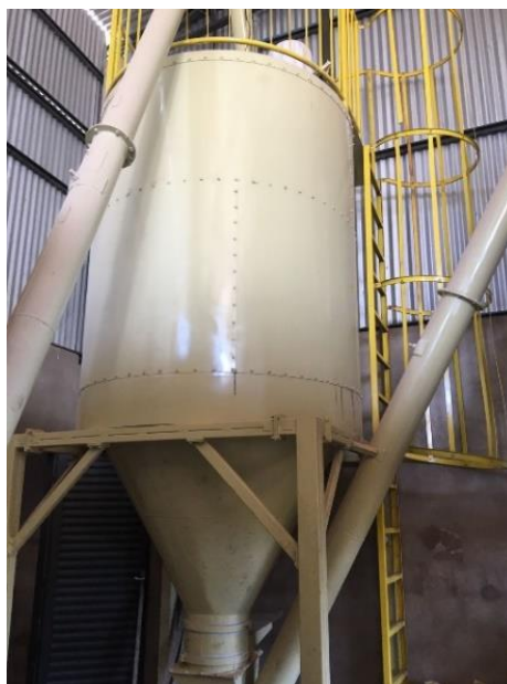
Figura 43 – Silo de armazenamento.
