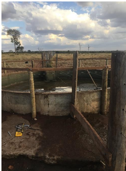
Figura 26 – Construção de contenção de madeira.
