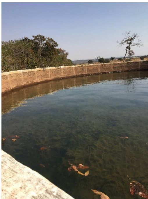
Figura 23 – Reservatório de água.
