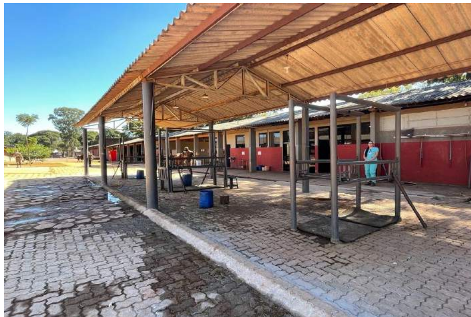
Figura 9- Troncos de contenção da Seção Veterinária do 1º Regimento de Cavalarias de Guardas Dragões da Independência, Brasília – DF.
