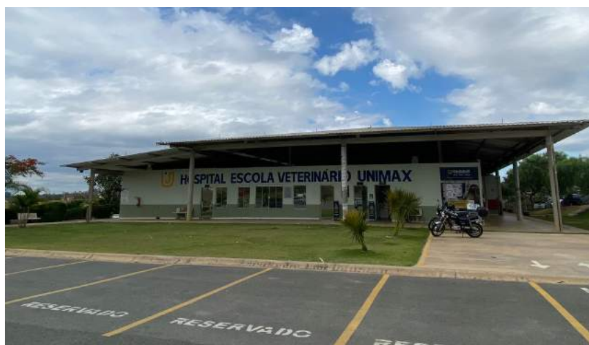
Figura 13- Fachada do Hospital Escola Veterinário Unimax (HEV-UNIMAX), Indaiatuba- SP.
