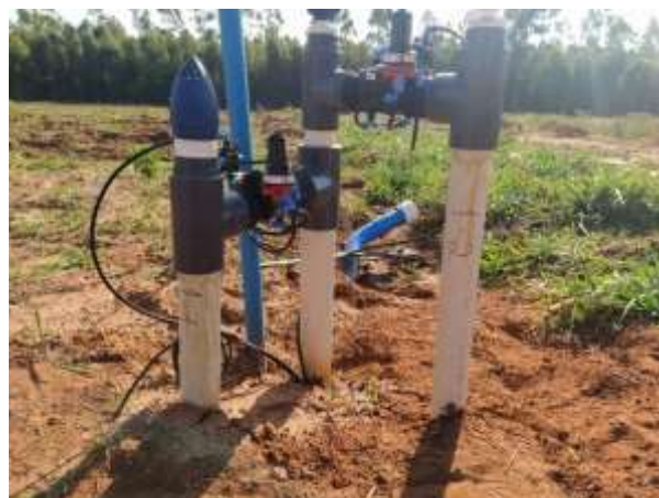
Figura 17 - Válvulas do sistema de irrigação
