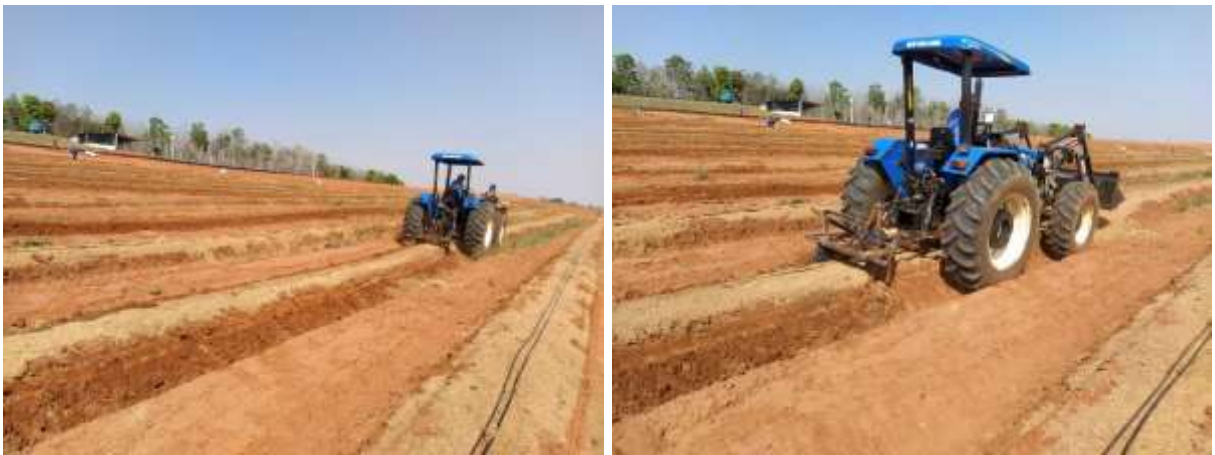
Figura 28 - Trator realizando operação de retirada de solo para implantação da manta
