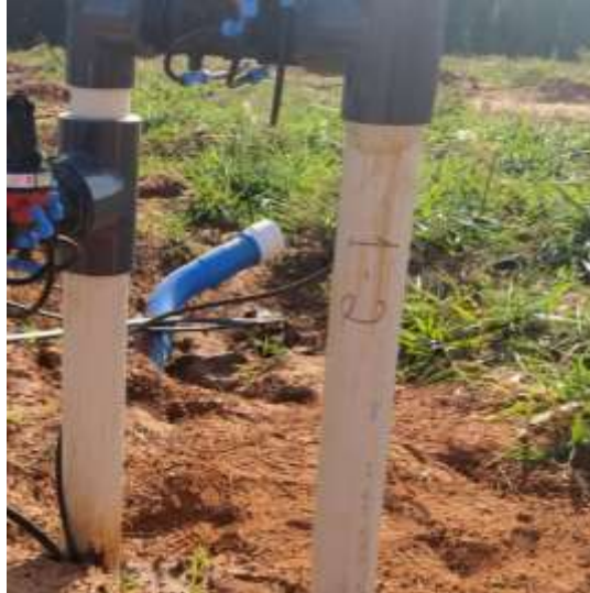
Figura 21 - Numeração das válvulas de irrigação
