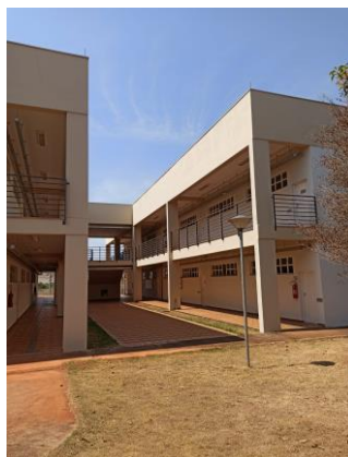
FIGURA 9: Sombreamento da edificação às 10:30h da manhã – Fachada Noroeste.
