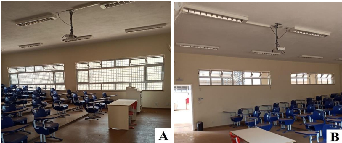
FIGURA 5: Aberturas laterais das salas de aula - (A) aberturas para a parte externa (B) aberturas para o corredor. FONTE: Autoria Própria (2021).
