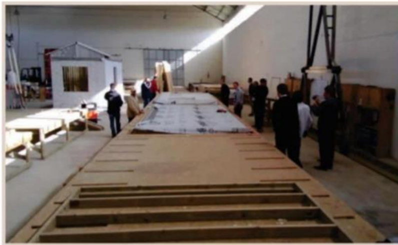
Figura 5.4 - Mesa de montagem dos painéis de parede.
