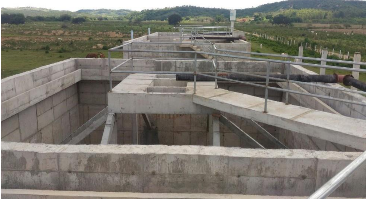
Figura 5 – Obras da ETE no município de Formiga-MG – Situação atual
