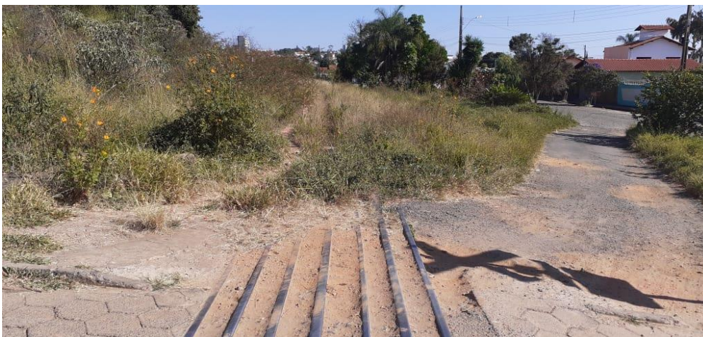
Figura 2 – Situação do ramal no bairro São Bernardo em Oliveira.
