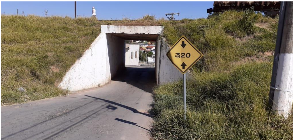
Figura 8 – Túnel por baixo do pátio ferroviário de Oliveira.
