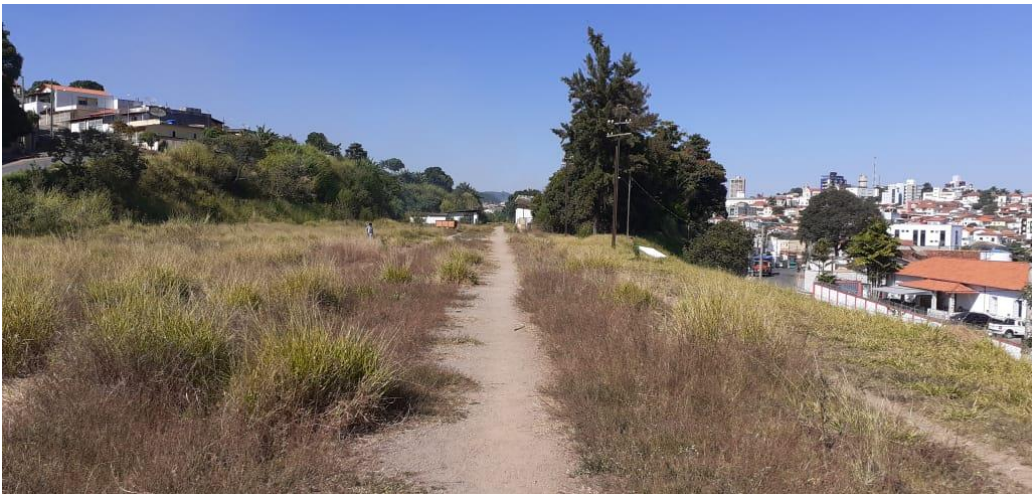
Figura 4 – Situação do pátio ferroviário de Oliveira (sob outra vista)
