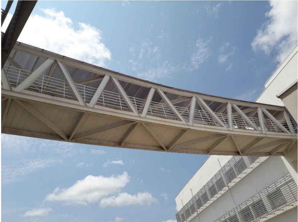
Figura 27 – Treliça que interliga os dois blocos do prédio da Medicina.
