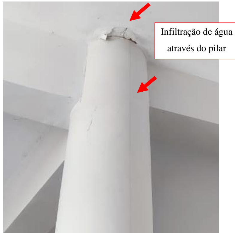
(a) Pilar de seção circular do 2º pavimento prédio da ABI.
