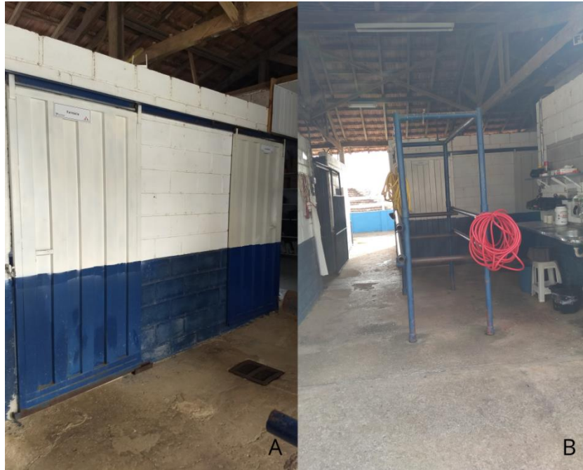
Figura 22: Bloco dois; entrada para farmácia e lavanderia (A) e tronco de contenção com bancada (B) do Centro Médico de Cavalos no período de estágio do dia 01/09/2021 ao dia 16/09/2021.
