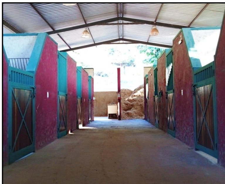
Figura 8. Vista do Pavilhão 3, evidenciando baias com portões baixos e altos, e depósito de serragem localizado no Vet Check Cirurgia e Medicina Equina, Betim – Minas Gerais.
