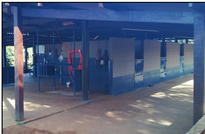
Figura 13. Vista lateral das baias localizadas no Hospital Veterinário Gonzales e Pereira, Batatais – SP.
