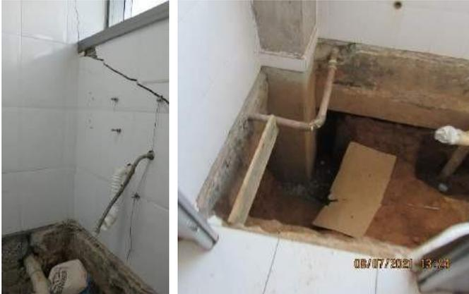
Inserir reforço estrutural em vigas do baldrame que apoiam alvenarias fissuradas ou esquadrias distorcidas, além das existentes e comprometidas na área dos banheiros.
