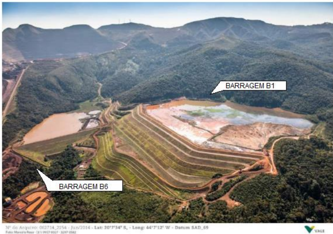
Figura 6 – Vista aérea da Barragem B1 e B6 em junho de 2014.
