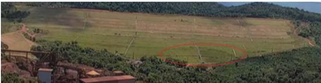
Figura 2 – Ruptura por liquefação da Barragem B1 de Brumadinho.
