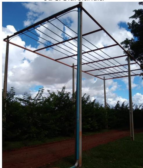
Figura 14 - Arco de desinfecção de veículos na entrada ao núcleo de aves - JBS/Sidrolândia
