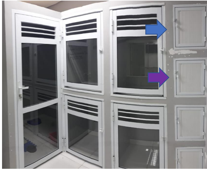
Figura 10 – Vista parcial da sala de pré e pós-operatório
