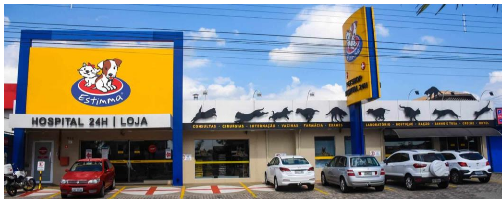
Figura 9– Vista da fachada do Hospital Veterinário Estimma
