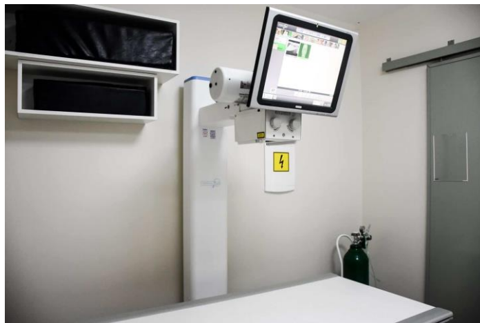
Figura 25 – Vista parcial da sala de radiologia
