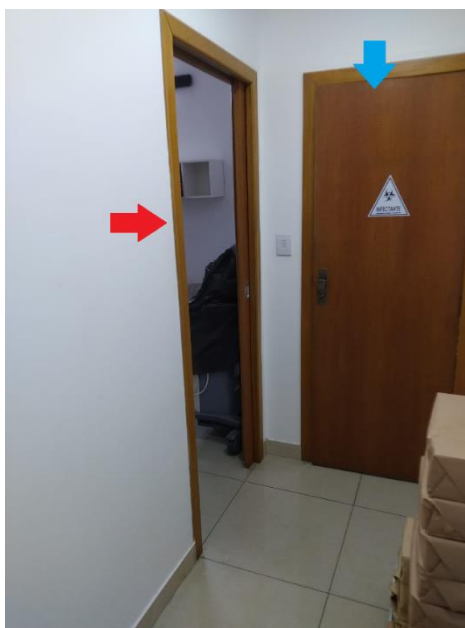
Figura 7 – Vista do corredor de acesso à copa e ao DML.
