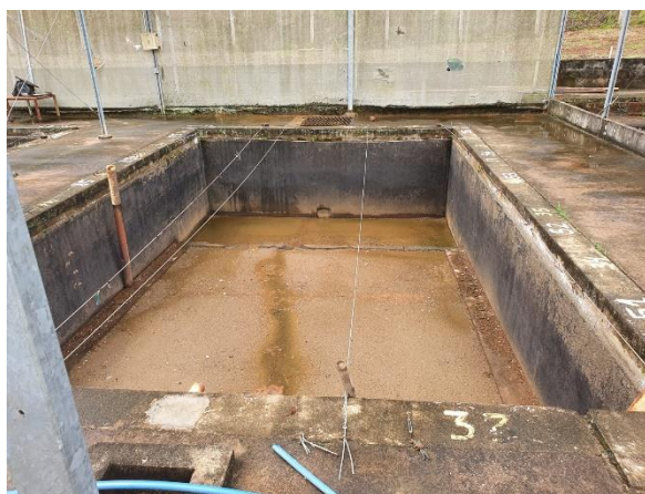
Ilustração 10. Tanque de alvenaria.
