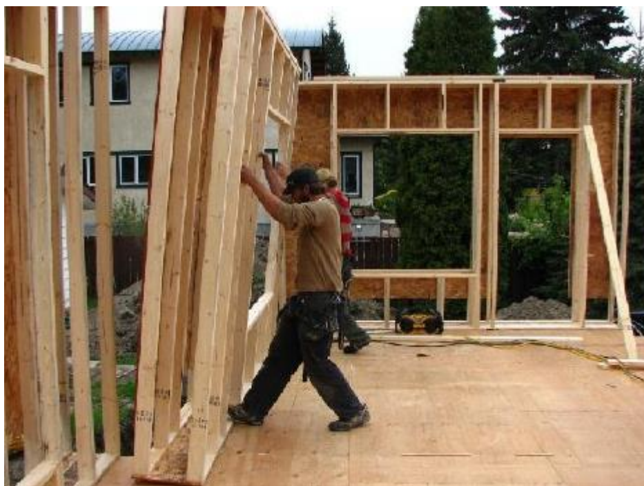
Figura 3 - Processo de montagem do wood frame.
