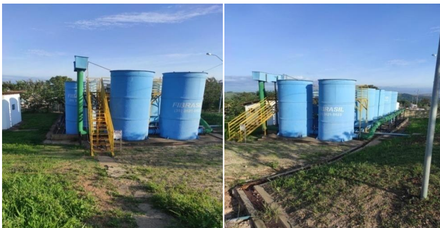
Figura 7- Estação de tratamento de água Luminárias MG
