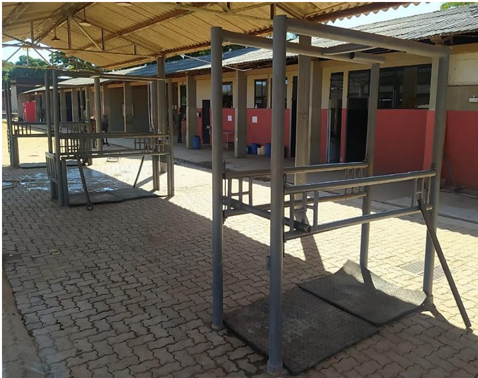
Figura 3 – Vista lateral da área central da Seção Veterinária Regimental do 1º RCG.
