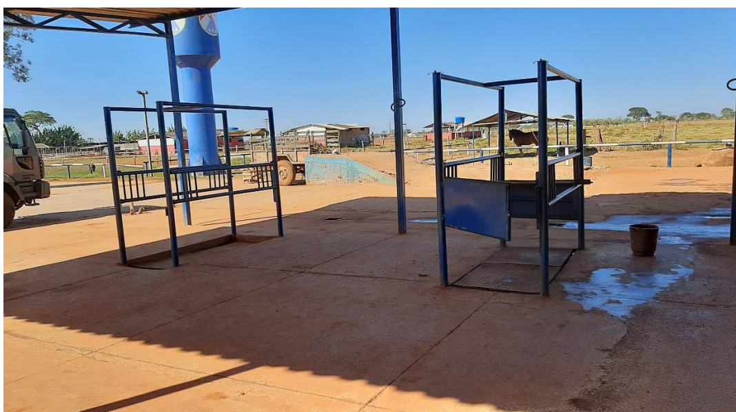
Figura 13 – Área central com troncos de contenção da Seção Veterinária da Bateria Caiena do 1º RCG.
