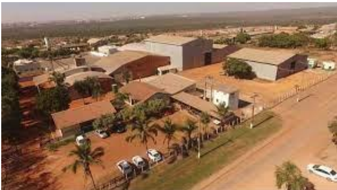
Figura 1- Vista da Fábrica em Rondonópolis
