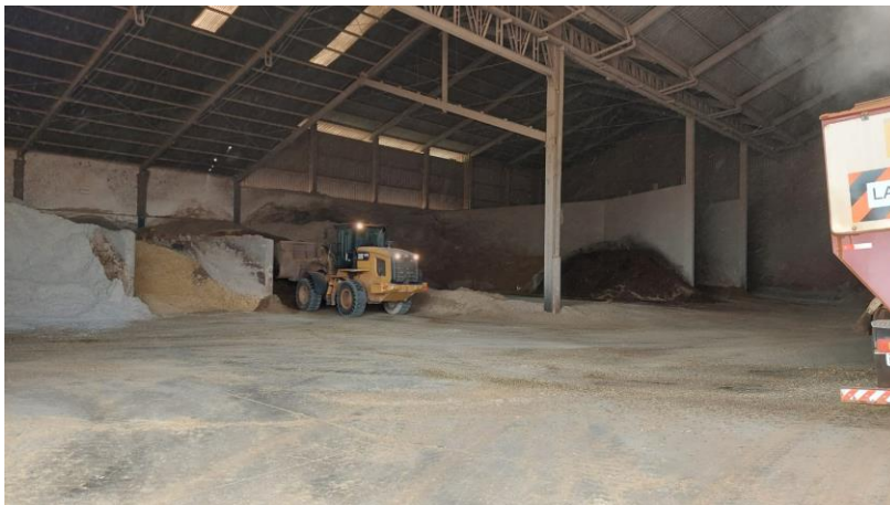
Figura 11 – Vista interna da fábrica de ração.
