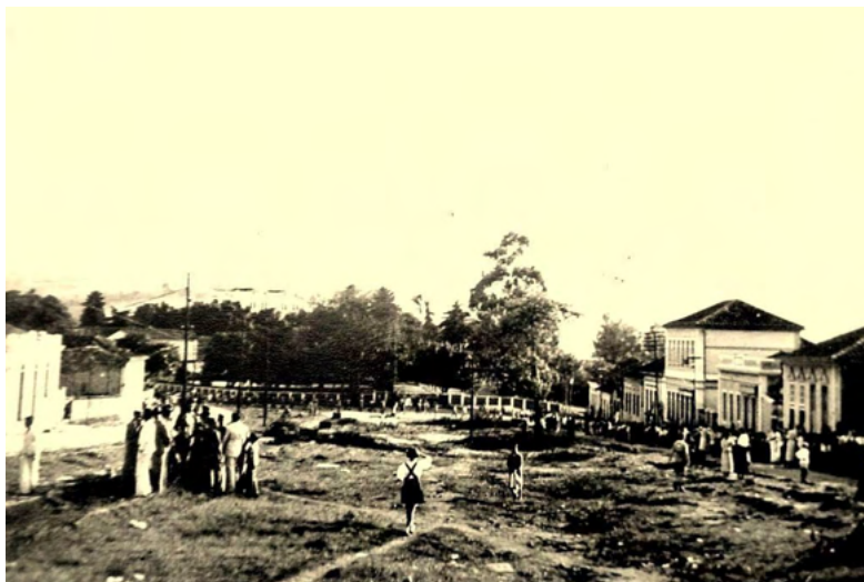
Figura 4 - A área após o corte das paineiras
