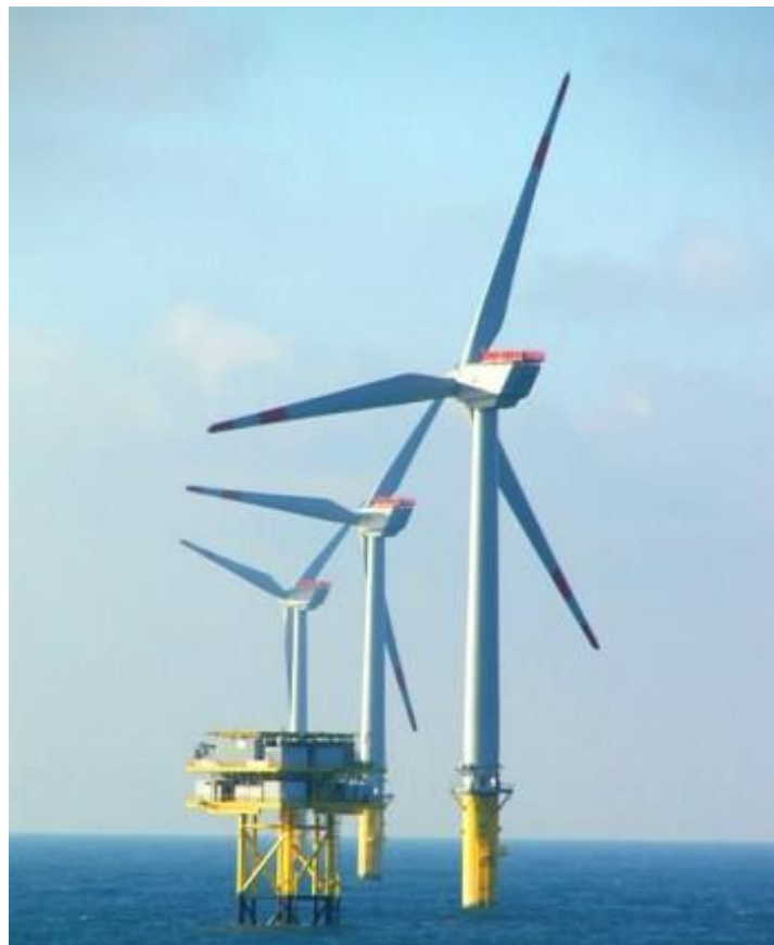
Figura 9 - Turbina eólica offshore .
