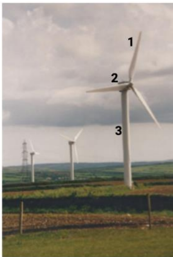
Figura 8 - Turbina eólica onshore . 1- Pás, 2- Nacele, 3-torre.
