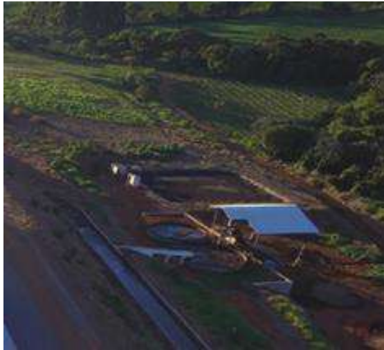
Figura 7- Local de tratamento de dejetos
